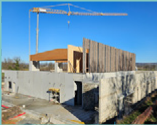
4 poutres principales en bois lamellé collé, pré-mur en lames béton ST chacune, 27 mètres de portée, élévations en panneaux bois
