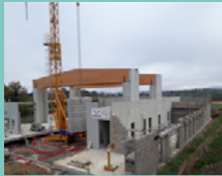
4 poutres principales en bois lamellé collé, pré-mur en lames béton ST chacune, 27 mètres de portée, élévations en panneaux bois
